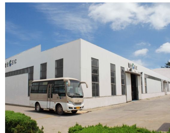
南京工厂 NanJing Plant
